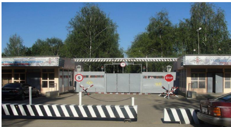
КПП бригады управления
